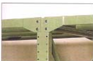
⑤頂面及底面之架樑須連結穩固,不可發生扭曲情形。
